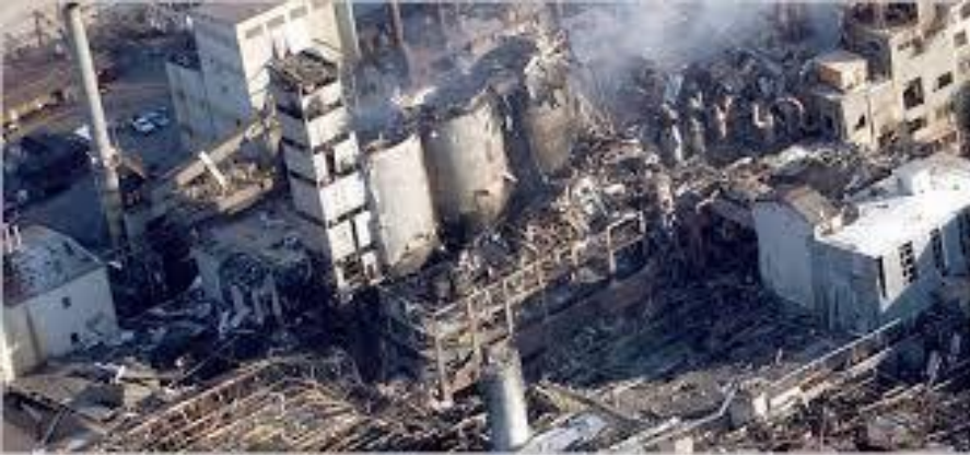
Şekil 40: Patlama sonrası fabrikanın durumu
